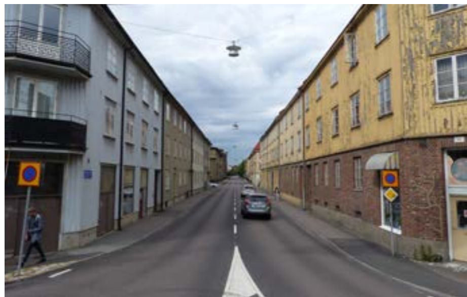
Fotopunkt B8, Fabriksgatan norrut vid korsningen med Underåsgatan.
